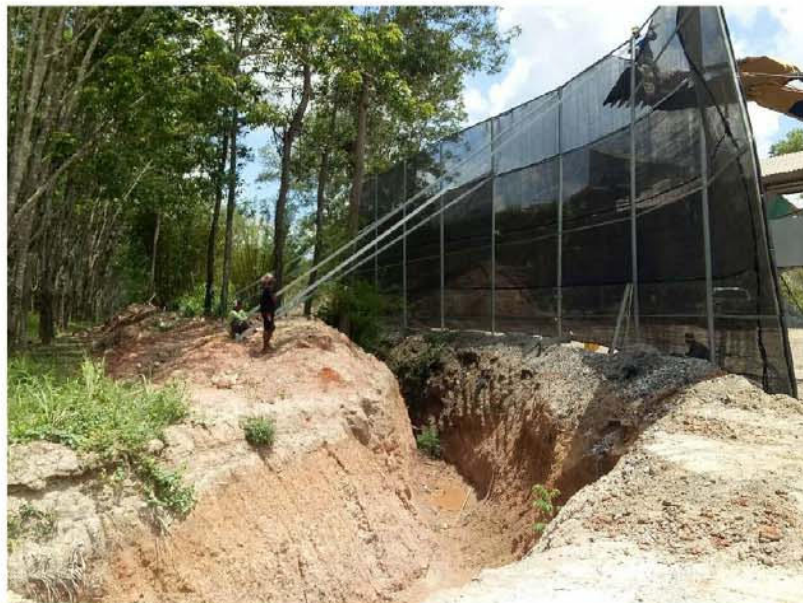
คูระบายน้ำรอบๆพื้นที่โรงแต่งแร่และแนวป้องกันฝุ่นละอองจากโรงแต่งแร่
